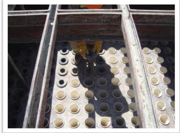
***Rasqueado y limpieza de chapa espejo - Colocación de mangas canastos.***
